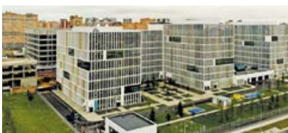
Больничный комплекс на 11 корпусов, пос. Сосенское/Коммунарка, Москва СКС Green, телекоммуникационные шкафы
