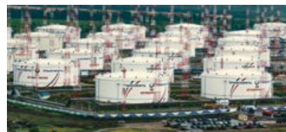
АО «Транснефть-Приволга» Модернизация структурированной кабельной сети в короткие сроки
