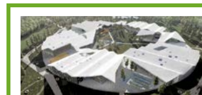
Образовательный комплекс «Умная школа», г. Иркутск СКС Green с самыми высокими требованиями по экологичности и пожарной безопасности
