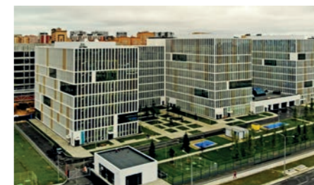
Больничный комплекс на 11 корпусов, пос. Сосенское/Коммунарка, Москва. СКС Green, телекоммуникационные шкафы
